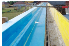
Coffrage sur voile ou au chaînage
